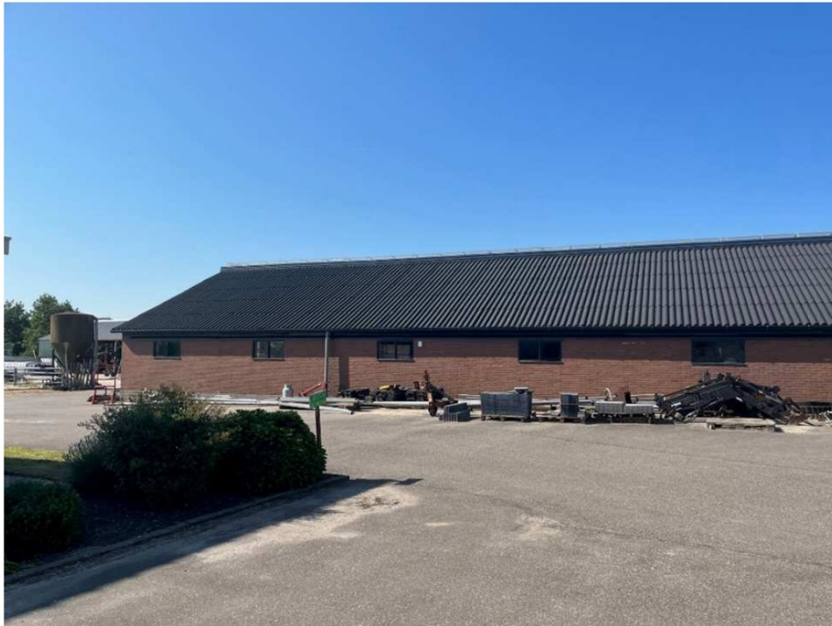
Foto 03 Deel bouwwerk B
