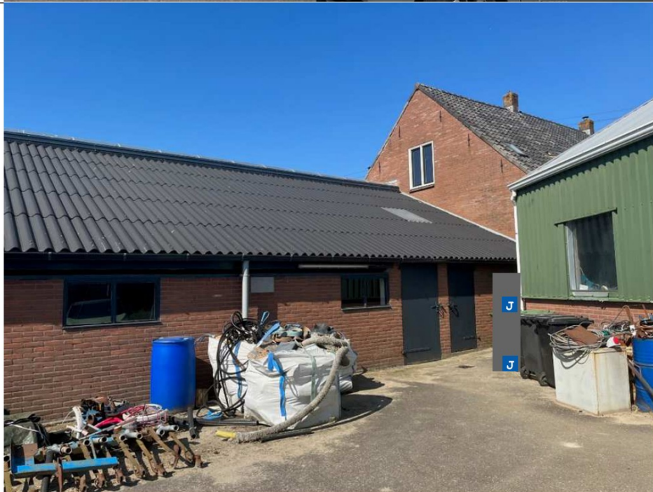
Foto 02 Deel bouwwerk B Aan de woning
