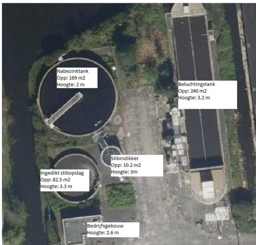
Figuur 1 Overzicht van de open onderdelen van de rwzi Ammerstol
