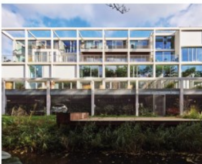
Private terrassen bovenop parkeergarage.
